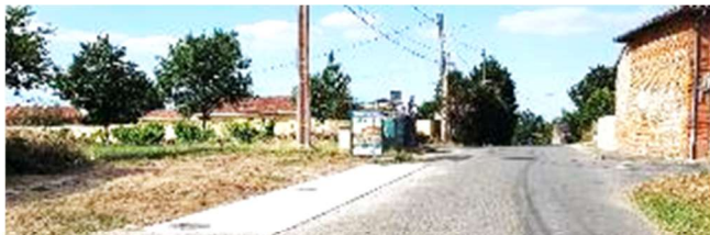
Derrière la Mairie, 2 colonnes enterrées OMR + Tri en accessibilité PMR, les colonnes Verres et Papiers devant être entreposées dans l'enceinte actuelle à la place des containers supprimés. Concernera : Village...
