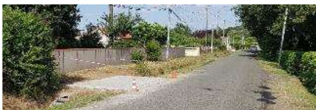
Route d'Esperce, 2 colonnes aériennes OMR + Tri devant desservir : Rieutarel, Rte d'Esperce et Fourcade...
