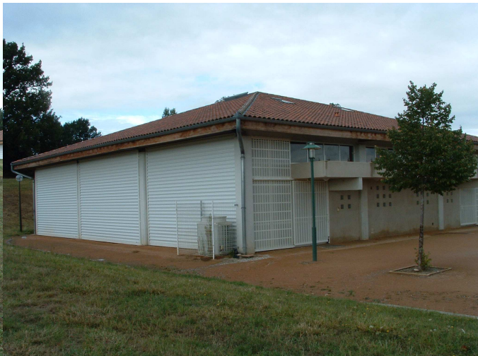
.....et mise en sécurité de la salle polyvalente.
